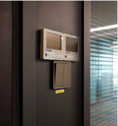
可选配电气封板，安置智能控制系统、开关面板线路。
